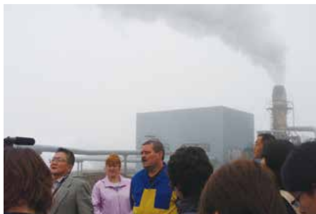
地熱発電所（第5回・択捉島）
